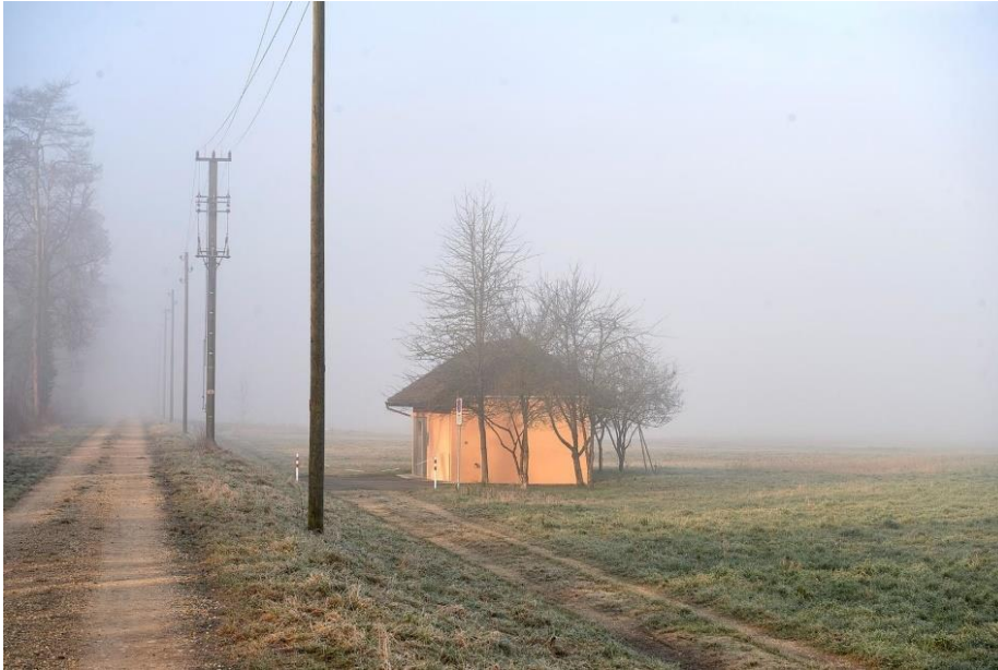
Vom Brunnenhaus in Walperswil erhalten rund 100'000 Menschen ihr Wasser.
